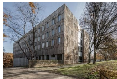
Fig. 6. Rénovation de l'Institut botanique de l'université de Liège
